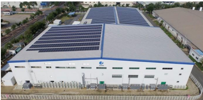
太陽光パネルを設置したADMS社の屋根全景
